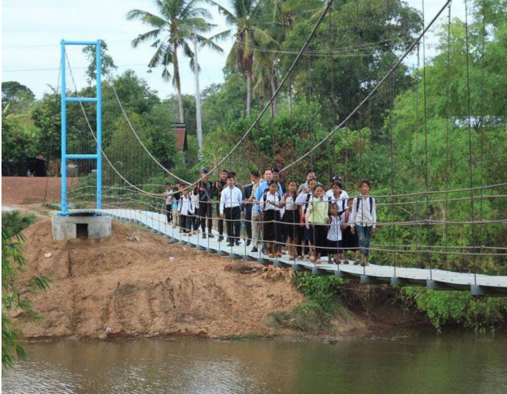
Pursatin alueen kylässä Luoteis-Kambodžassa tulvat romahduttivat kouluun johtavan sillan. Lähetysseuran tukemana kyläläiset onnistuivat rakentamaan uuden sillan sortuneen tilalle. (Kuva: Suomen Lähetysseura)
