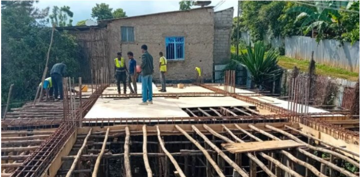
Levyjen laittoa välipohjan valua varten. (Kuva: Alemayhu Kebede, Ethiopian Jimma/Kansanlähetys)
